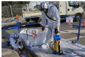
**1/ Opérations de découpe d'enrobés** au marteau piqueur ou à la scie, de détournage de regards, ou d'engravures réalisées à l'aide de petites raboteuses (largeur rabotage <1m), de reprises de nids de poule, de carottages pour caractérisation/investigation, diagnostics de chaussées, etc.
