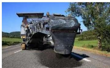
2 / Le matériau fraisé est ensuite homogénéisé, incorporé et malaxé avec le liant d'apport (émulsion biosourcée, ou mousse de bitume, ou liant hydraulique) par **la machine de**
