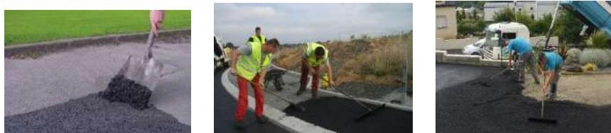
Pour réduire les contraintes physiques : manutentions répétitives à la brouette (une brouette de 60 litres d'enrobé pèse 140 kg), travail manuel de pelletage, de ratissage) : lors de l'enrobage *des trottoirs, allées, pistes cyclables, îlots, rond-point, tranchées réseaux humides et secs*, on peut utiliser :
