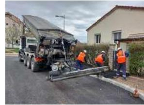
En situation d'approvisionnement, le chauffeur quitte sa cabine et commande le déplacement du camion à distance, il peut également gérer la descente et la montée de la benne, l'ouverture de la bâche, le débit et l'orientation de la vis convoyeuse.
