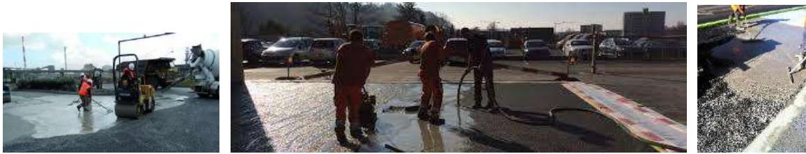
Ce sont des produits spéciaux, principalement utilisés pour le revêtement de chaussée **en raison de leurs résistances mécaniques élevées**.
