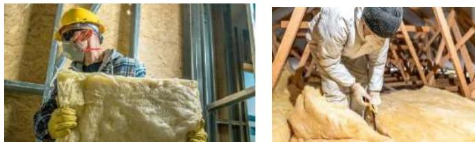
Les matériaux biosourcés sont des matériaux issus de la matière organique renouvelable d'origine végétale ou animale, ils peuvent être utilisés sous forme d'isolants (sous toiture, sous plancher, sur parois), en paroi verticale , et en enduit de finition (en intérieur comme en extérieur).
