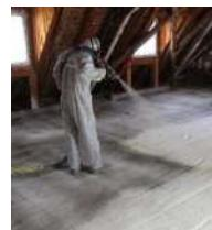
Pour éviter les **chutes** dans les espaces confinés (combles ou les greniers) , **peut utiliser un platelage sûr : treillis antichute** en matériau composite, isolé, au cas où il serait posé sur des câbles électriques cachés (**115 cm par 48 cm une fois replié** ) **passant facilement par les trappes d'accès.**
