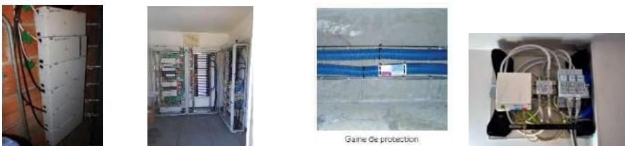
Les câbles de fibre optique cheminent dans les sous-sols jusqu'aux colonnes montantes (cages d'escalier avec goulettes ou gaines de protection) par les chemins de câbles existants dans les parties communes ou si les chemins de câble existants traversent une partie privative ou sensible (cave, box de parking, chaufferie, ...), la fibre optique est protégée par une gaine.
