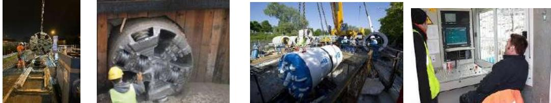
*Matériels nécessaires* : éléments du micro-tunnelier, stations de poussée (principale et intermédiaires), module sas d'accès, groupe hydraulique, pompes de transfert de déblais, système de séparation des boues (desableur, hydrocyclone, centrifugeuse), vannes, automates assurant le pilotage et le contrôle des stations de poussée ; l'asservissement des vannes d'injection et de lubrification ; des vérins.
