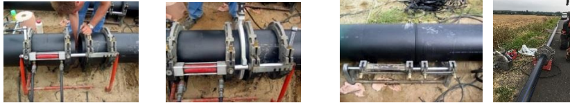
Soudure bout à bout au miroir
