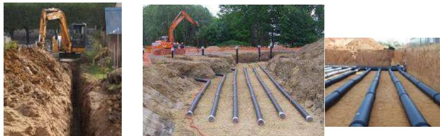
Lorsque le système est composé de plusieurs collecteurs disposés en parallèle, l'espace de travail dans la fouille devient plus important ,le blindage/talutage n'est pas nécessaire .
