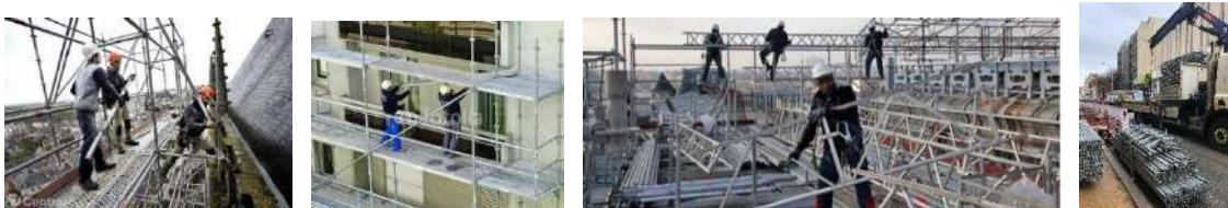
Equipement provisoire de chantier, l'échafaudage permet l'accès aux postes de travail en hauteur, pour la réalisation de travaux de construction, d'entretien ou de réfection de bâtiments.
