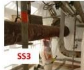
3/ Retrait ponctuelle de calorifuge amianté pour mise en place de vannes pilotées à distance sur toute la ligne
