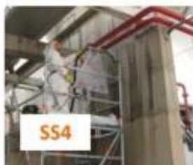
2/ Remplacement d'un joint amianté fuyard sur bride non amiantée
