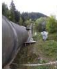
4/ Rénovation complète de la couche de protection anticorrosion amiantée d'une conduite forcée
