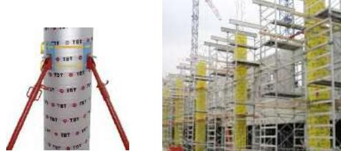
Met en place deux étais tirant-poussant positionnés à 90°,permettant un réglage rapide de la verticalité ; leur maintien est réalisé par l'écrou situé sur la tige filetée à pas rapide.
