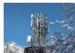
Cette station de base comprend : un support d'antennes (pylône dans la plupart des cas, mât fixé sur un toit d'immeuble , ou sur le sommet d'un château d'eau, d'une tour, d'un silo ; façade ou terrasse de bâtiment) ; des antennes réceptrices- émettrices reliées à une baie électronique dans un local énergie ventilé ou climatisé.
