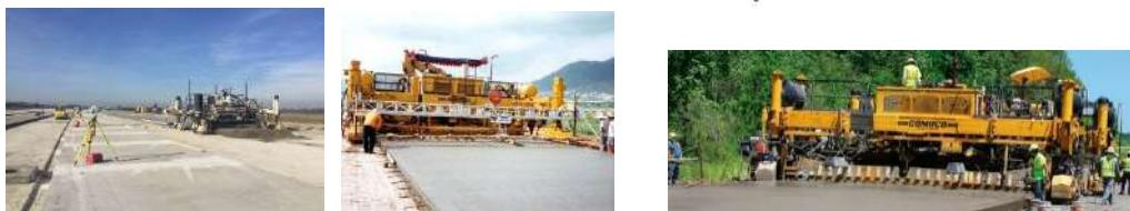
Le coffrage glissant met en forme le revêtement en béton pendant que la machine avance. Parallèlement, des vibrateurs électriques assurent un compactage du matériau par vibrations à haute fréquence.
