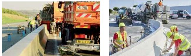
Utilise un pulvérisateur manuel dédié, équipé d'une buse à jet plat.
