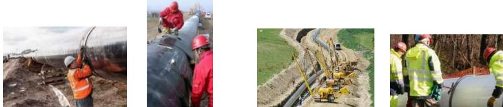
**- Ouvre la tranchée et met en fouille la canalisation :** l'ouverture de la tranchée s'effectue en deux temps : la terre végétale (la plus fertile) est enlevée et entreposée le long de la piste de travail ; puis les déblais de fond de tranchée sont stockés séparément ;
