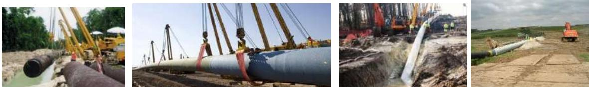
La construction d'une canalisation de transport de gaz est réalisée « **en ligne** » : les travaux sont décomposés en différentes opérations qui sont réalisées chacune **par une équipe spécialisée**.
