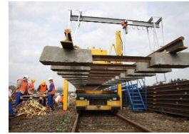
Pose traverses béton
