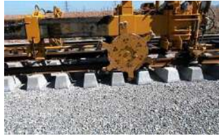
Pose traverses béton
