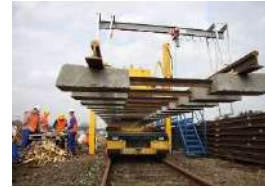
Pose traverses béton
