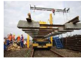
Pose traverses béton
