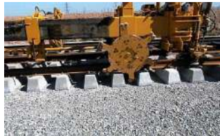
Pose traverses béton
