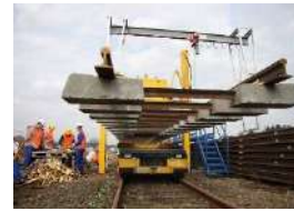
Pose traverses béton
