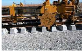
Pose traverses béton
