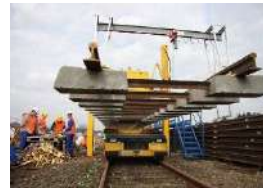
Pose traverses béton
