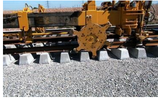
Pose traverses béton
