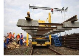
Pose traverses béton
