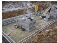
Parois en parpaings
