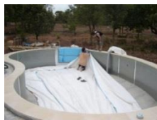
Mise en place liner
