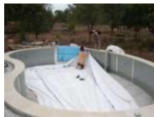
Rail accrochage liner Mise en place liner Aspirateur
