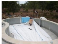
Mise en place liner
