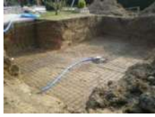
Ferrailage coulage radier
