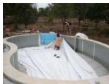
Mise en place liner
