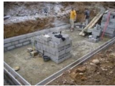
Parois en parpaings
