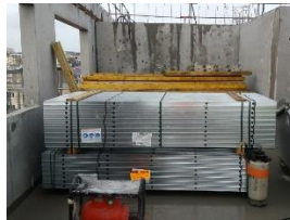
Approvisionnement plaquiste dans les niveaux. ©OPPBTP
