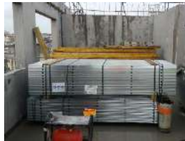
Approvisionnement plaquiste dans les niveaux. ©OPPBT
