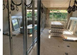
Une fois à l'étage , pour le transport des plaques, à intérieur du chantier utilise un transpalette , ou un chariot à roulettes , avec 4 roues directionnelles , équipé de pinces pour bloquer les plaques ( évite le basculement) et profil en H permettant aisément le passage de porte , afin d'éviter des manutentions manuelles lourdes.
