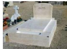
Un monument funéraire (poids total = 750 kg à 1 tonne) se compose d'éléments généralement en granit ou en marbre : il est composé d'une semelle, d'un soubassement, d'une pierre tombale (300 kg), d'une stèle (200 à 300 kg), possibilité d'une jardinière, d'un prie-Dieu, de sculptures et autres éléments.
