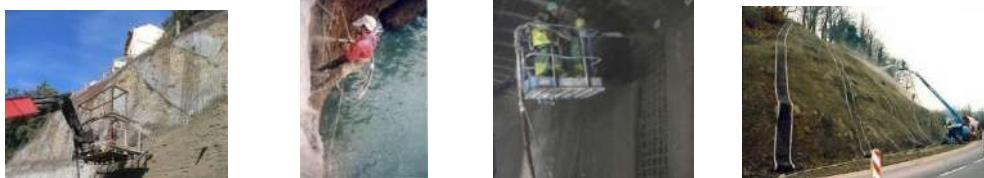
Pour le béton de structure, il est impératif de ne pas « travailler » le matériau tant qu'il n'est pas raidi ; le dressement est alors effectué par recoupe avec une règle biseautée ou à la tranche de la truelle ; dans le cas d'une demande de finition spécifique, il est conseillé de projeter, après dressement de la dernière couche du béton de structure, une couche finale de faible épaisseur (de l'ordre du centimètre) qui pourra être travaillée à l'état frais.
