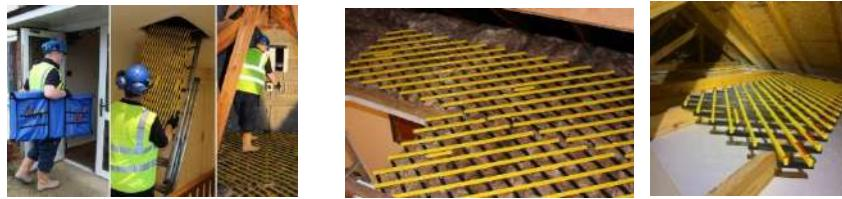
Utilise une échelle **uniquement comme moyen d'accès** ; elle doit reposer sur des appuis stables et être bloquée en pied ou en tête.
