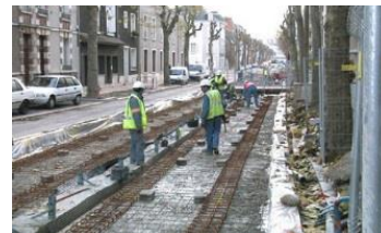
Pose avec ancrage dans le béton
