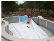
Mise en place liner
