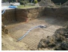
Ferrailage coulage radier
