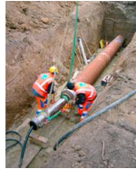
Marteau pousse tube par battage
