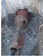
Marteau pousse tube par battage
