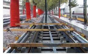
Pose sur traverses noyées dans un béton
