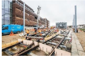
Pose sur traverses noyées dans un béton
