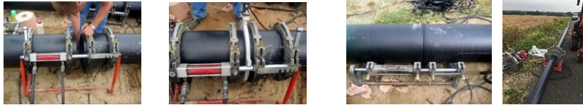
Soudure bout à bout au miroir
